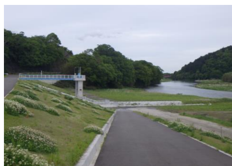
野口排水樋管（手前）と 那珂川大橋（奥）
