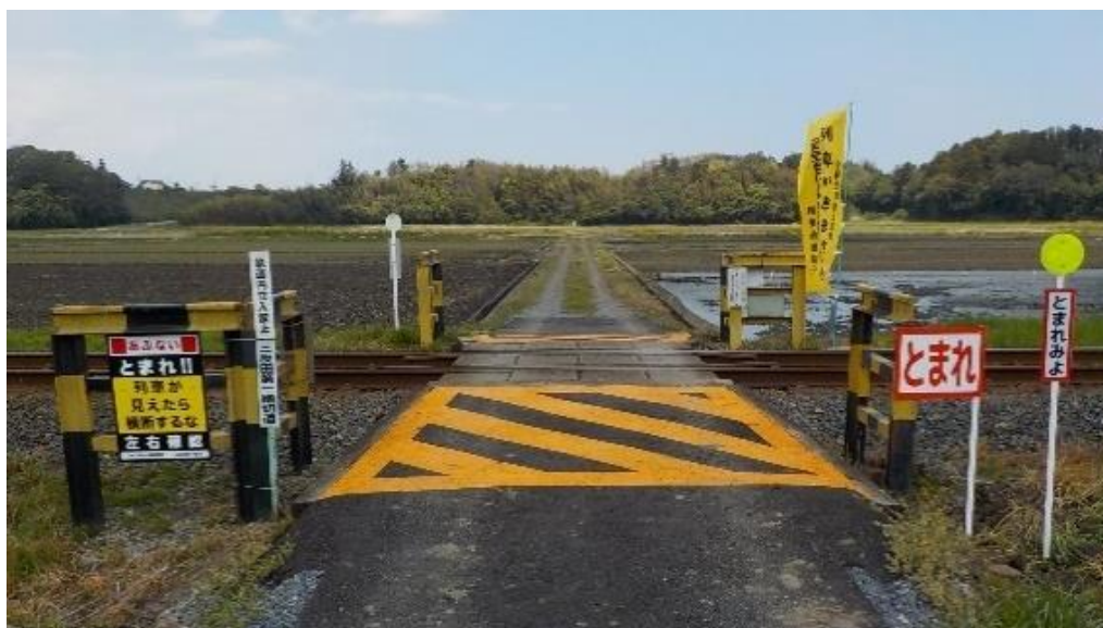
第4種踏切への注意喚起標識設置と路面標示の状況
