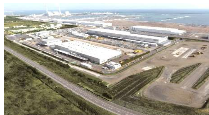
上空から見た茨城工場
