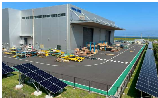
2024年度に稼働開始した海浜工場太陽光発電
