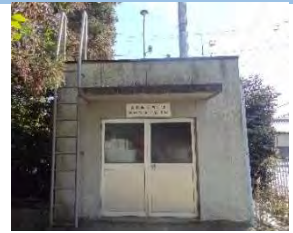
市役所敷地内の大気測定局
