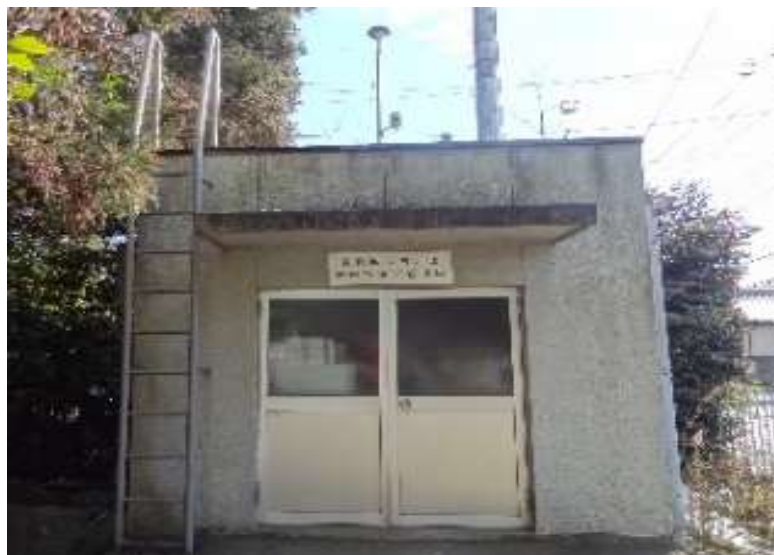
市役所敷地内の大気測定局
